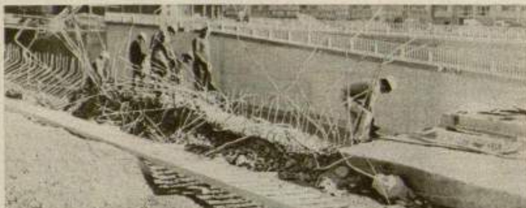
El Cinturón de Ronda es una obra en general poco afortunada. Política de prioridad automovilística, oposición del vecindario y errores, de vez en cuando, como en el caso que ilustra la foto: en el tramo comprendido entre Avda. de Madrid y Travesera de Les Corts, unos obreros proceden a demoler una baranda mal colocada.
